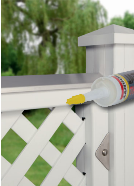
Designaufsatz Alu mit MS-Polymer-Kleber (1398) befestigen.
